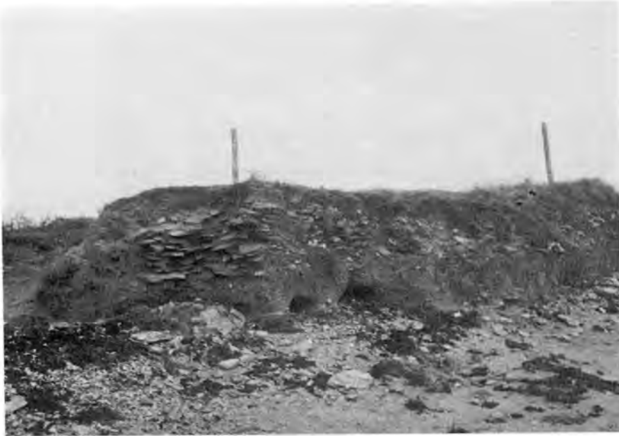
Le « mur du Roi » coupé par l'érosion marine (sous le pieu de gauche) : pointe Er Fosse, Le Tour-du-Parc.
