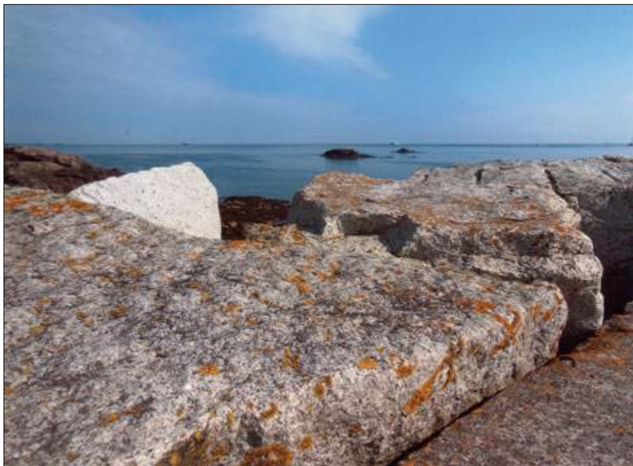
La jetée du port de Molène est enrochée avec d'énormes blocs en granite du Huelgoat.
