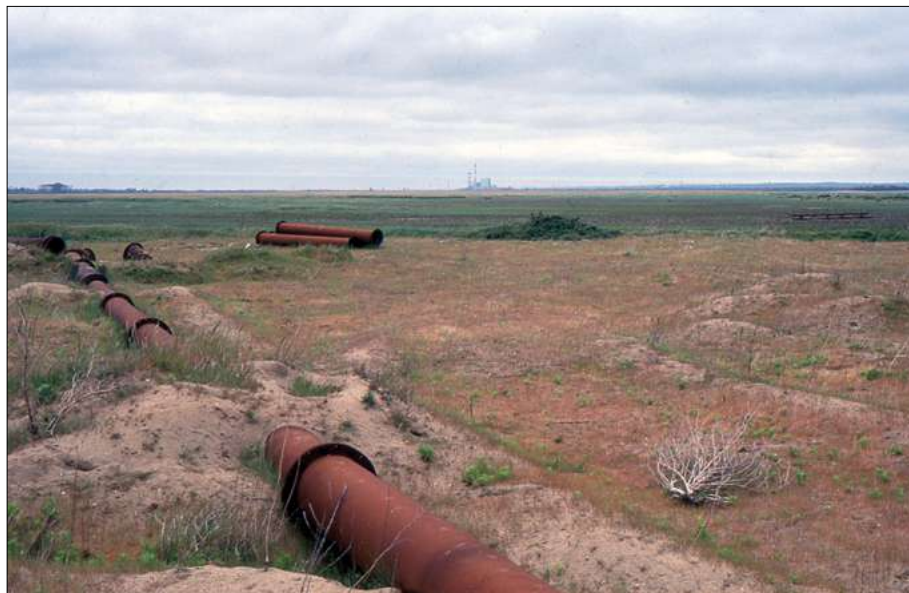
[4] Zone remblayée de Donges-Est. Au loin, la centrale électrique de Cordemais.
