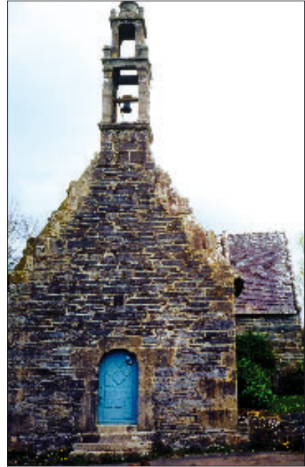
À gauche, haut : Église de Saint-Sauveur ; élévation sud. Moellons de schiste bleu et de granite gneissique brunâtre. À gauche, bas : Chapelle Saint-Yves à Pen ar Guer ; soubassement et entourage des ouvertures en granite de Plounéour-Menez ; élévation en moellons allongés de granite gneissique avec quelques calages de schiste bleu. À droite, bas : Église Sainte-Anne en Lampaul-Guimiliau ; large prédominance du schiste bleu sur le granite.
