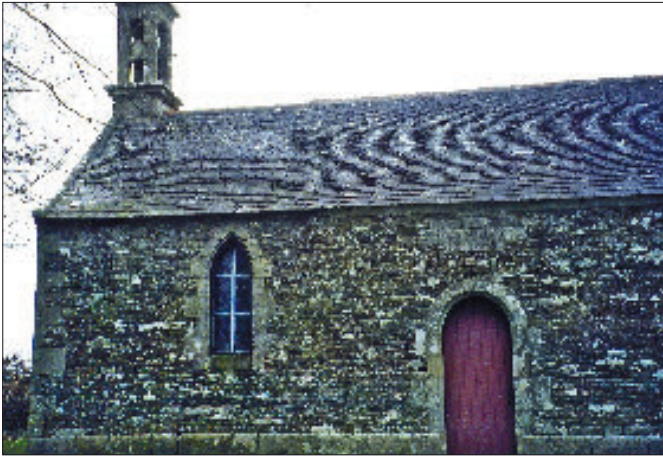
À gauche, haut : Église de Saint-Sauveur ; élévation sud. Moellons de schiste bleu et de granite gneissique brunâtre. À gauche, bas : Chapelle Saint-Yves à Pen ar Guer ; soubassement et entourage des ouvertures en granite de Plounéour-Menez ; élévation en moellons allongés de granite gneissique avec quelques calages de schiste bleu. À droite, bas : Église Sainte-Anne en Lampaul-Guimiliau ; large prédominance du schiste bleu sur le granite.
