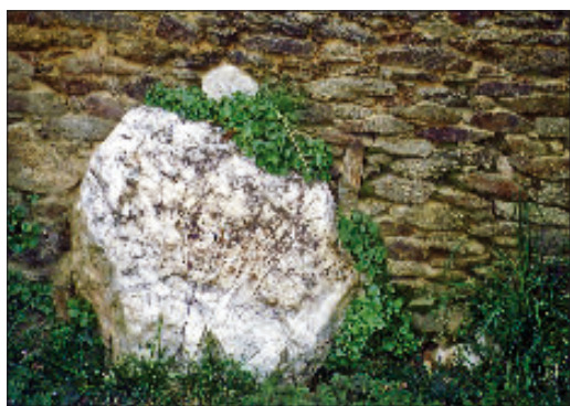
En haut : bourg de Lampaul-Guimiliau ; dans une ruelle à proximité de l'église ; porte avec linteau à accolade, en granite de Plounéour-Menez ; moellons schisteux, plus rarement quartz. En bas : Traonlen ; en énorme bloc de quartz en soubassement ; moellons en granite gneissique.
