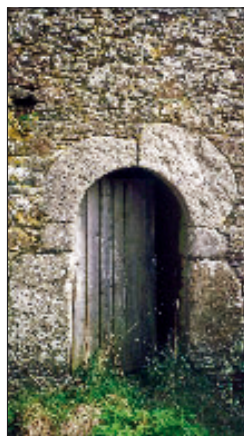
À gauche : Kergaradec ; maison abandonnée ; porte cintrée en granite de Plounéour-Menez ; Moellons en granite gneissique. À droite : Creac'h Gorniel ; granite de Plounéour-Menez en chaînage d'angle ainsi qu'en moellons ; moellons de gneiss granitique, hétérométriques.
