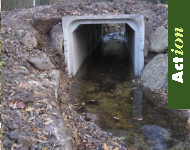
Exemple d'aménagement d'un ouvrage (à gauche) qui limitait la circulation des poissons et des sédiments par la pose d'un pont cadre (à droite).
