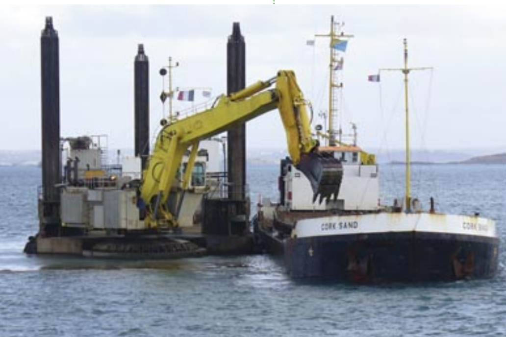
En juillet 2010, les travaux avancent aussi en mer.
