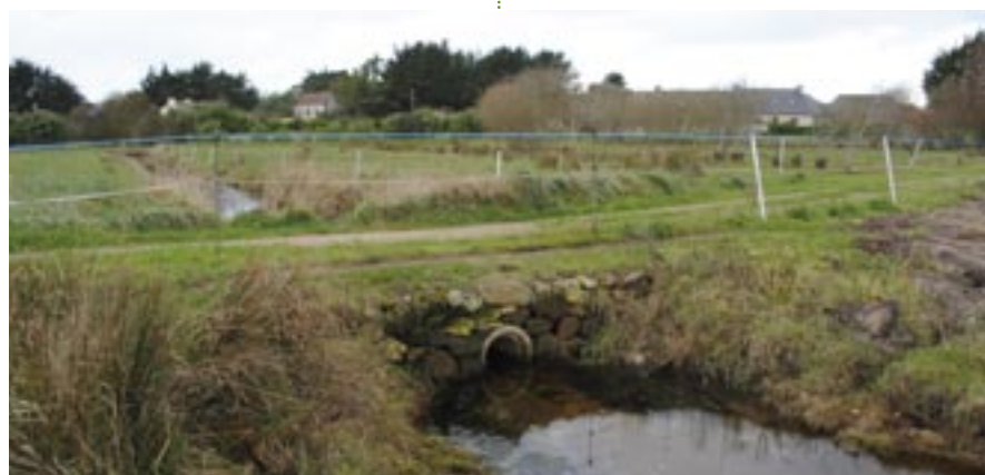
Les fossés de drainages, les buses et, à droite, les déblais de la rigole creusée en décembre 2011 dans l'enclos où séjournent des poneys.
