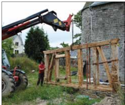
Pose d'une ossature bois en châtaignier réalisée par Jean-Pascal Adrast, charpentier au Cloître-Saint-Thégonnec.
