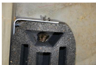
Figure 12 : Oreillard roux dans un gîte artificiel installé au niveau du passage inférieur
