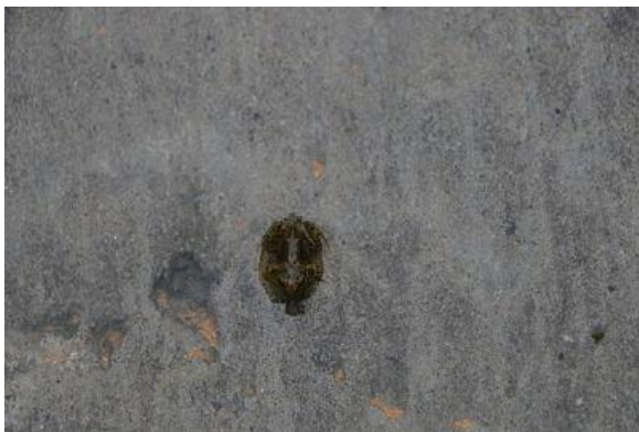
Figure 48 : Grenouille rousse se desséchant sur l'ouvrage
