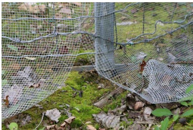
Figure 38 : Problème d'étanchéité du grillage
