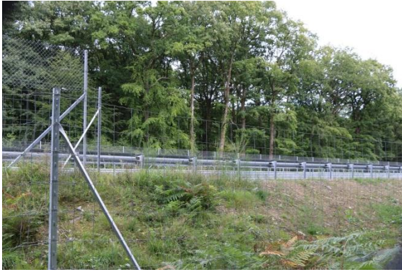
Figure 62 : Surélévation positionnée sur un seul côté de la route
