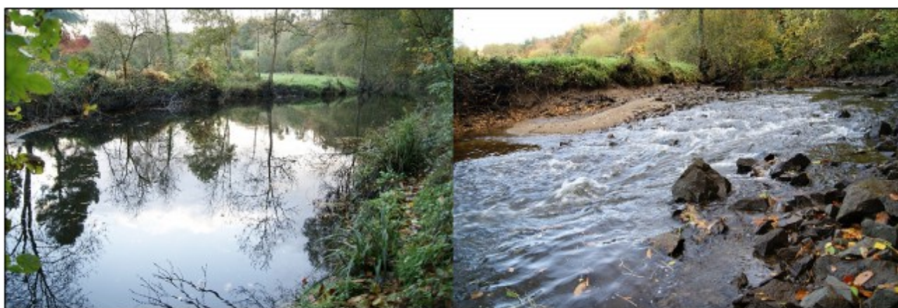
Avant et après travaux © Hubert Catroux
