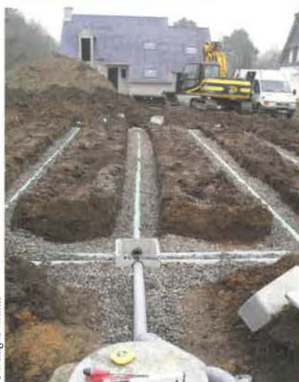
Le système d'Assainissement non collectif le plus courant.
