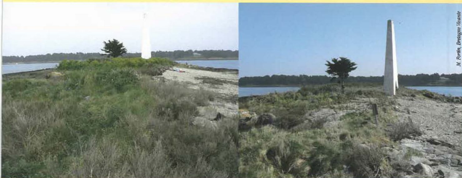
Cordon de galets au pied de l'amer au Petit Veizit en 2007 (à gauche), puis en 2008 (à droite).
