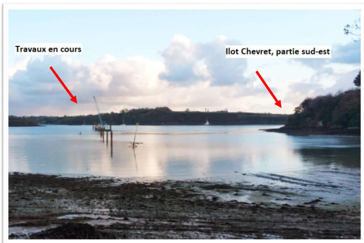
Photo 1. Travaux d'installation d'une conduite d'eau potable à proximité de la partie sud-est de l'îlot. Source : Eau du Pays de Saint-Malo
