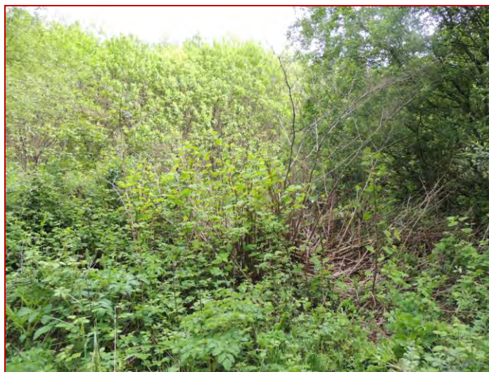
Figure 29. Site « Station épuration 4» le 25/05/2016
