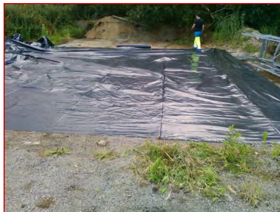
Figure 34. Pose de la bâche
