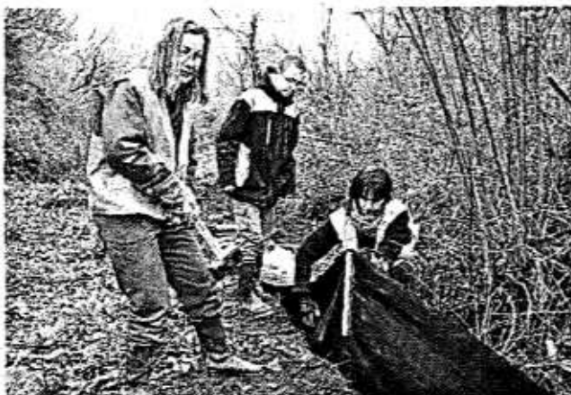
Les bénévoles ont tracé une rigole en bordure de forêt et installé un corridor avec des piquets et bâche plastique.
