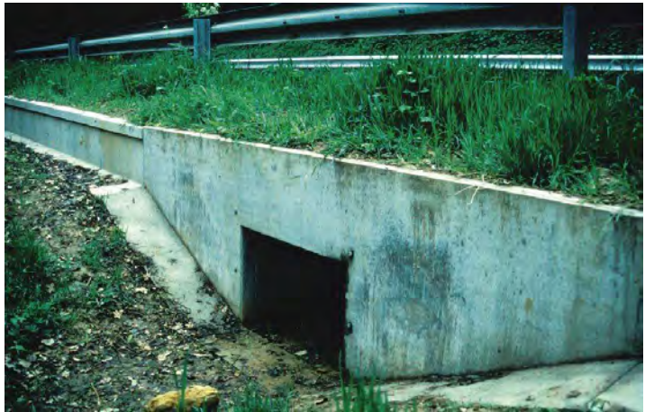
Illustration 19 - Rendu des passages sous voies préconisés – Rapport faune et trafic (voir Bibliographie) – Photo J. Niederstrasser
