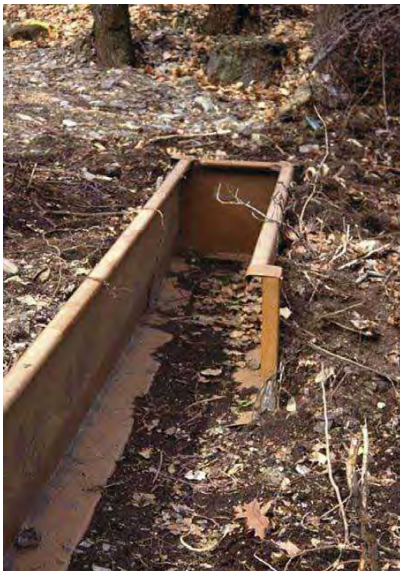
Illustration 20 - Fin de la barrière en U pour obliger les amphibiens à faire demi-tour – Photo S. Zumbach
