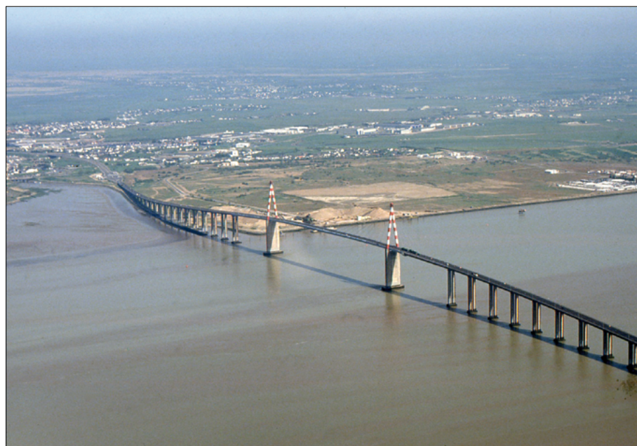
[3] Le pont de Saint-Nazaire avec à gauche la vasière du Grand Tourteau (ou vasière de Méan) ; à droite du pont, la zone portuaire de Montoir en cours d'aménagement (année 1994)
