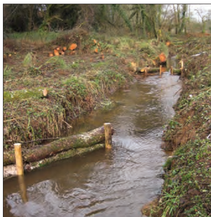
Restauration hydromorphologique avec matériaux issus de la gestion de la ripisylve
