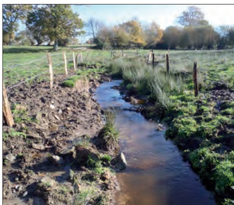
Mise en place de clôture barbelée protégeant le cours d'eau des bovins
