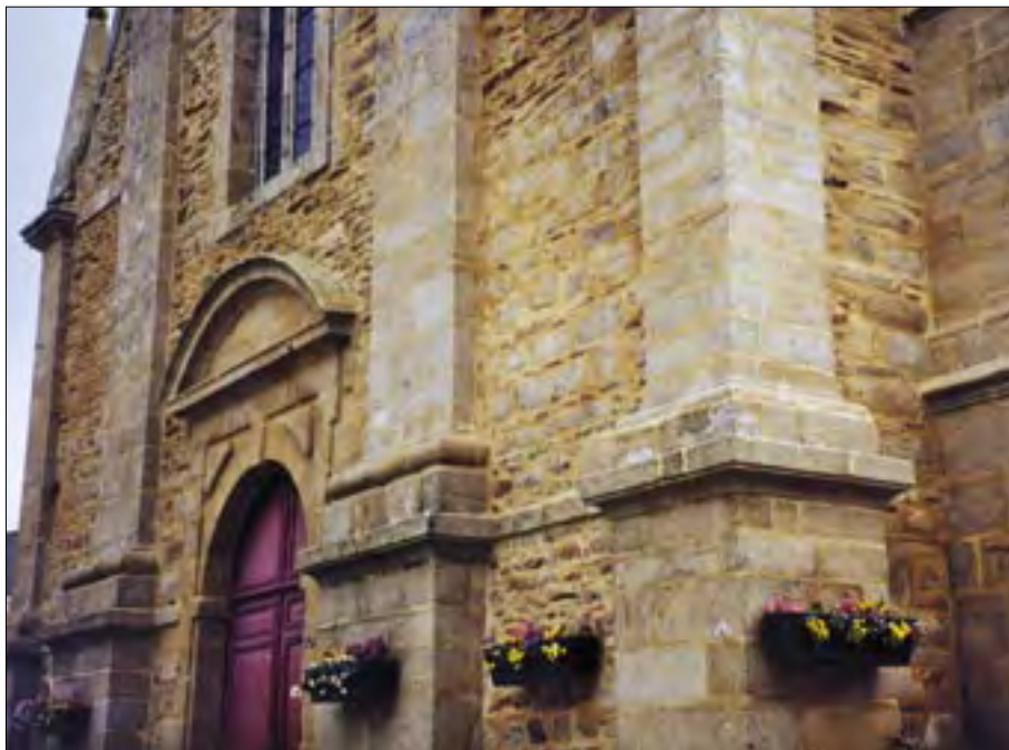
Façade occidentale de l'église paroissiale de Sarzeau. Contreforts et portail en pierres de taille façonnées dans un granite fin gris à ocre (26/04/2004).
