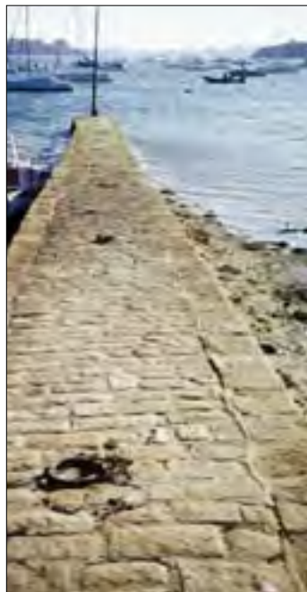
De gauche à droite : menhir de Kermaillard (Sarzeau) en granite à grain fin. Desquamation locale (22/04/2004) ; pilier granitique de la nef à Saint-Gildas-de-Rhuys (22/04/2004) ; cale du Bilouri au nord de Kerners. Appel à un granite à grain fin de provenance proximale (15/10/2009)
