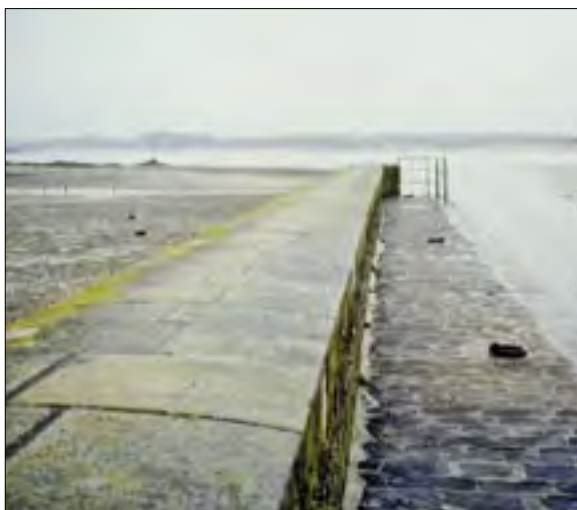
À gauche : couronnement du parapet de la jetée de Saint-Jacques (partie « amont ») en granite de l'Île aux Moines (21/04/2004) ; à droite : couronnement du parapet du môle de Billiers en granite de l'Île aux Moines (15/04/2009).
