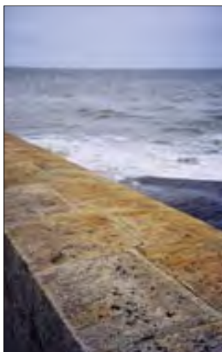
À gauche : couronnement du parapet de la jetée de Saint-Jacques (partie « amont ») en granite de l'Île aux Moines (21/04/2004) ; à droite : couronnement du parapet du môle de Billiers en granite de l'Île aux Moines (15/04/2009).
