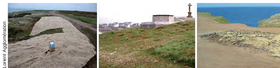
[4] Restauration active de la végétation (de gauche à droite : pose de géotextile, transplants de motte, enlèvement de route)
