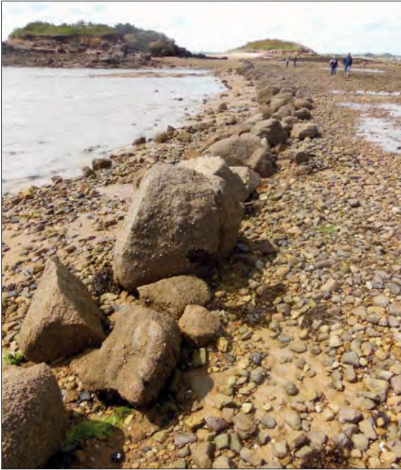
[53] Entre Ru Lann et Le Run en Carantec. Voie submersible empierrée en galets, bordée par un alignement de blocs granitiques (24/05/2016).
