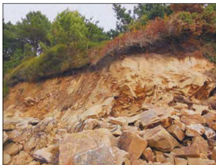
[9] Grève du Cosmeur à Carantec. Au pied de la falaise granitique en cours d'éboulement, déversement en vrac de blocs en granite, en provenance d'une carrière voisine.
