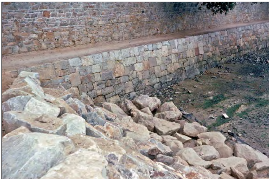
[1] Vilin Vraz à Saint-Pol-de-Léon. Contraste saisissant entre le mur ancien, en maçonnerie, et les enrochements récents, en vac.
