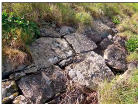
[2] Le Vivier-sur-Mer. Enrochement littoral du type « perré », en granite du Mont-Dol.
