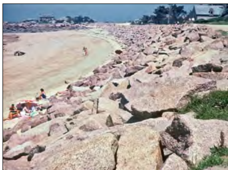
[13a et 13b] Île Renote. Accès bordé par un long enrochement de blocs hétérométriques en granite rose de La Clarté, irrégulièrement juxtaposés.
