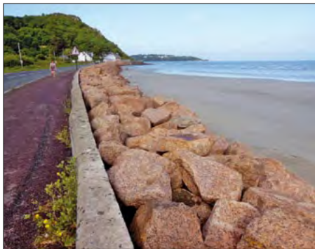
[14a et 14b] Entre Plestin et Saint-Michel-en-Grève. En bordure de la route longeant la Lieue de Grève, enrochements en granite de La Clarté.
