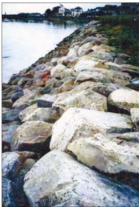
[42] Port d'échouage de Roscoff. Enrochement récent (1989) au fond du port, en provenance de Roc'hinigo.
