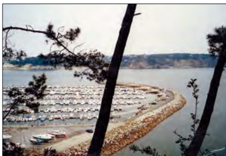
[39] Gauche : port de plaisance de Morgat en Crozon. Vue d'ensemble soulignant l'importance des enrochements en grès armoricain (10/05/2006). 40. Droit : port de plaisance de Morgat en Crozon. Enrochements en grès armoricain (10/05/2006).
