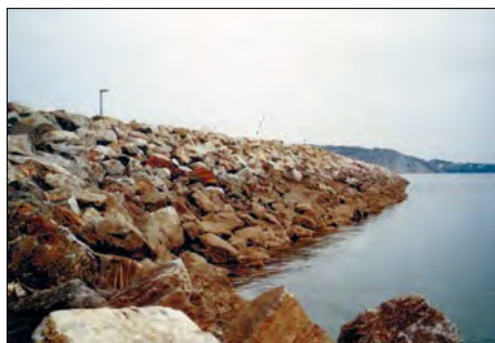
[39] Gauche : port de plaisance de Morgat en Crozon. Vue d'ensemble soulignant l'importance des enrochements en grès armoricain (10/05/2006). 40. Droit : port de plaisance de Morgat en Crozon. Enrochements en grès armoricain (10/05/2006).
