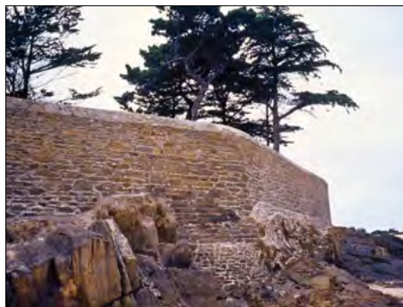
[20] Grève Blanche à Carantec. Grandes plaques de granulats cimentés, remplaçant le mur en maçonnerie emporté par une tempête.
