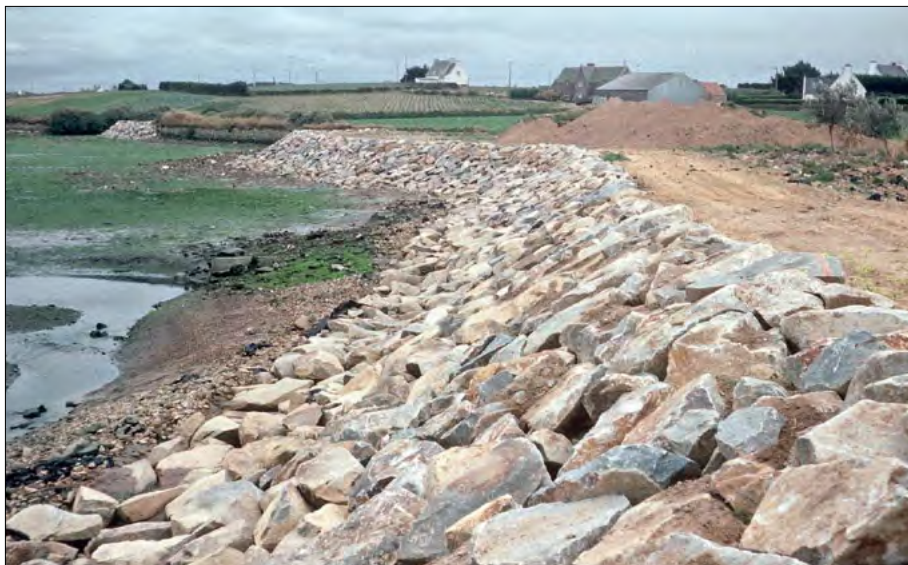
[54] Saint-Pol-de-Léon. Enrochement à proximité de la station d'épuration (21/09/1990).
