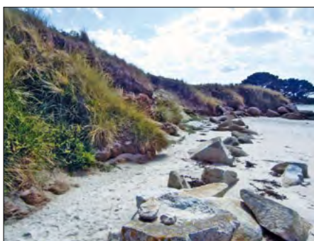
10a et 10b. Île Callot. Plage au sud de la tourelle Mazarin. Enrochement inutile...
