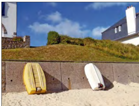
[20] Grève Blanche à Carantec. Grandes plaques de granulats cimentés, remplaçant le mur en maçonnerie emporté par une tempête.
