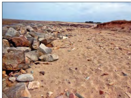
[11a et 11b] Sillon de Talbert. Inefficacité des enrochements.
