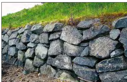
[55] Gauche : Landévennec. Aux approches du mur du cimetière, enrochements récents en blocs informes de dolérite en provenance de Lopérec.
