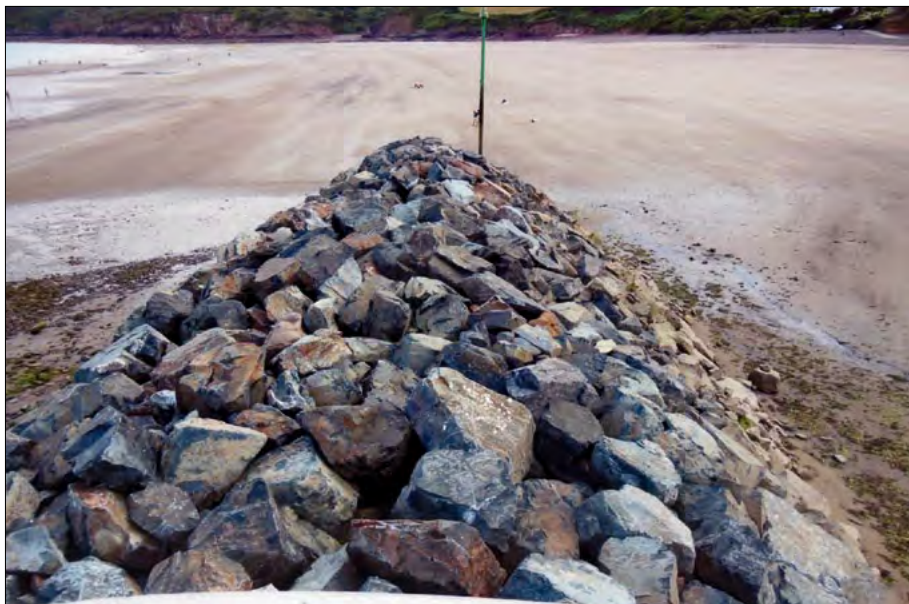
[41] Bréhec. Épi en enrochement prolongeant le môle.
