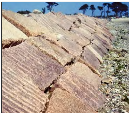
[12a et 12b] Tombolo de l'îlot Sainte-Anne à Saint-Pol-de-Léon. Enrochement en énormes blocs parallélépipédiques soigneusement assisés, façonnés dans le granite rose de La Clarté.
