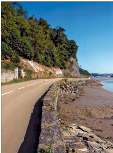
[18] Route de corniche entre la Pennelé et Locquéholé. Mur de soutènement de la route, au droit de l'accès à l'eau de Toul Mahot, en beaux moellons schisteux, de provenance proximale, régulièrement assisés (circa 1839).
