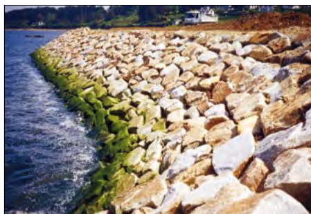
[43] Haut : port de Molène. La jetée est enrochée par d'énormes blocs en granite du Huelgoat (16/05/2016).
