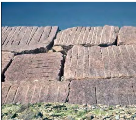
[12a et 12b] Tombolo de l'îlot Sainte-Anne à Saint-Pol-de-Léon. Enrochement en énormes blocs parallélépipédiques soigneusement assisés, façonnés dans le granite rose de La Clarté.
