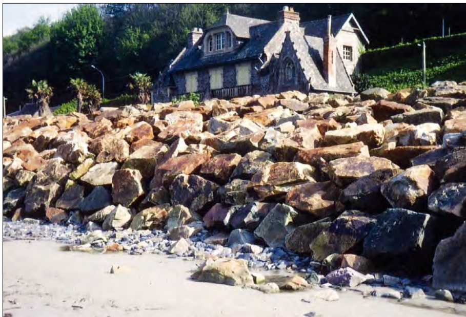
[15] La Lieue de Grève près de Saint-Efflam. Puissant enrochement en provenance de la carrière de Dividou.
