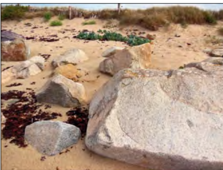
[11a et 11b] Sillon de Talbert. Inefficacité des enrochements.
