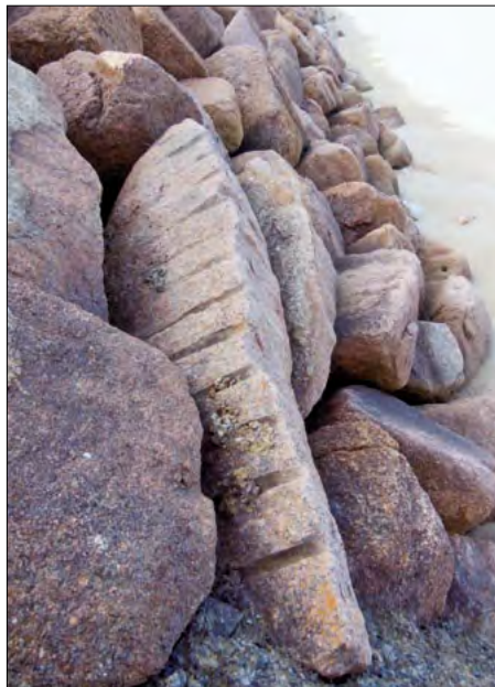
[14a et 14b] Entre Plestin et Saint-Michel-en-Grève. En bordure de la route longeant la Lieue de Grève, enrochements en granite de La Clarté.
