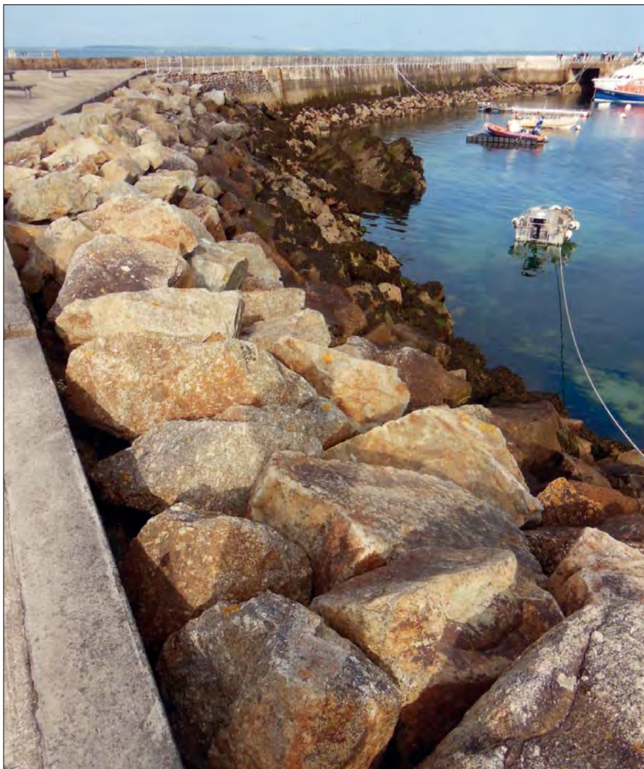
[29] Le Conquet. Renforcement du terre-plein par des enrochements en granite porphyroïde de l'Aber-Ildut et en granite à grain fin de Saint-Renan.
