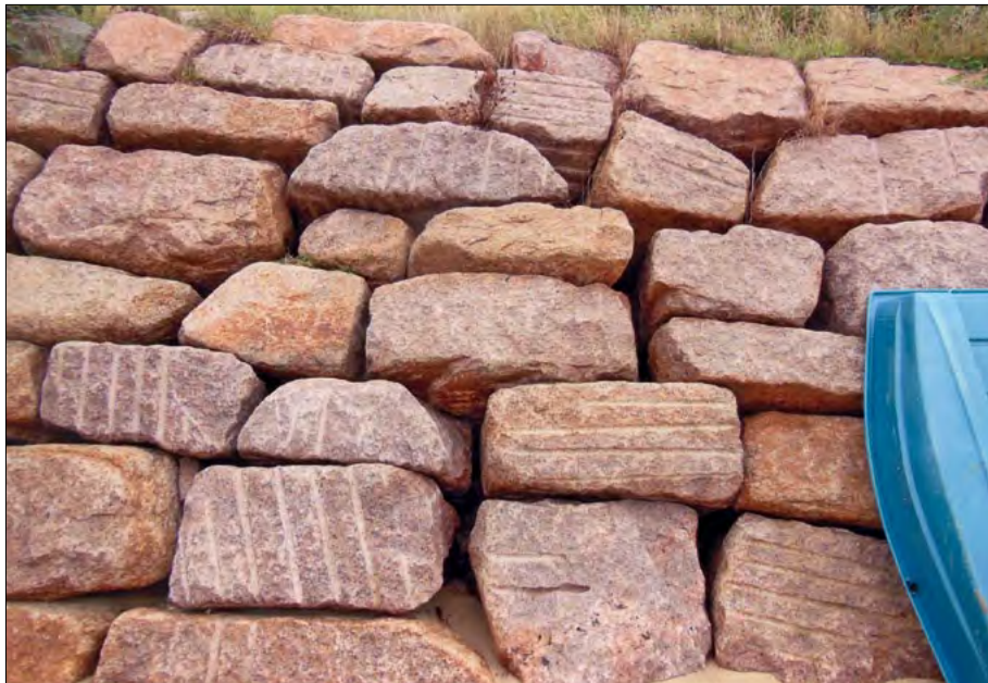
[23] Grève de Porz Paol à Carantec. Nouveaux enrochements, en granite de La Clarté (24/08/2016).
