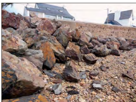
[17] Carantec. À l'entrée de la route vers l'île Callot, enrochement en schistes et quartzites.
