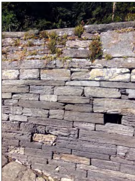
[18] Route de corniche entre la Pennelé et Locquéholé. Mur de soutènement de la route, au droit de l'accès à l'eau de Toul Mahot, en beaux moellons schisteux, de provenance proximale, régulièrement assisés (circa 1839).
