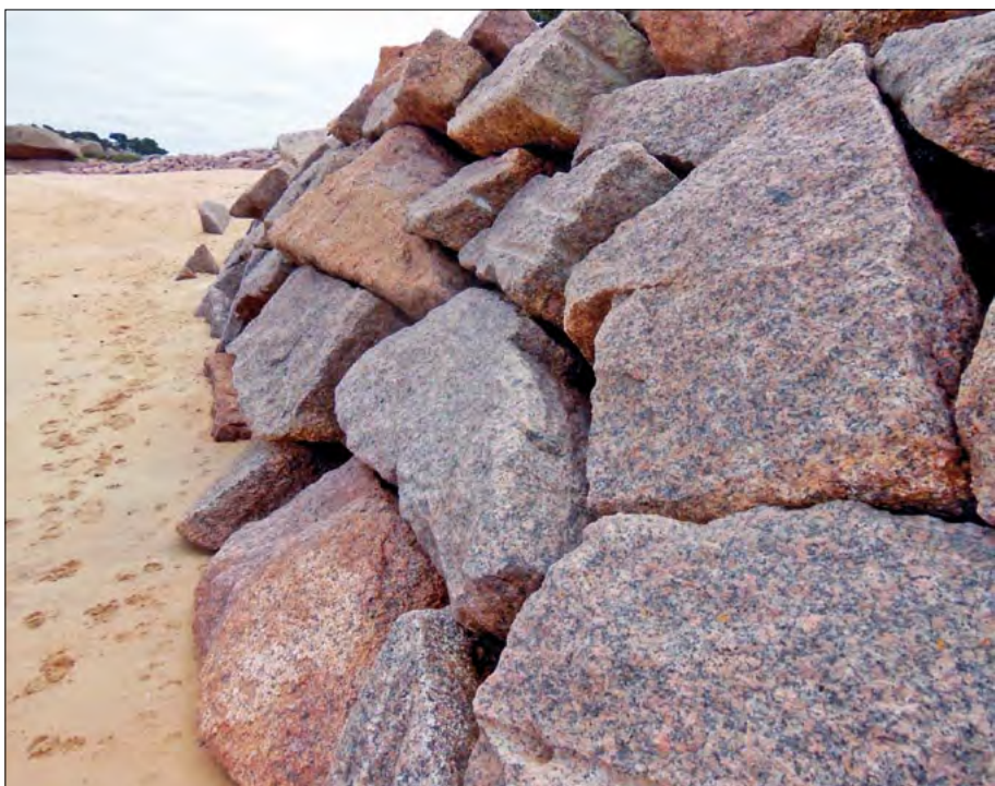
[12a et 12b] Tombolo de l'îlot Sainte-Anne à Saint-Pol-de-Léon. Enrochement en énormes blocs parallélépipédiques soigneusement assisés, façonnés dans le granite rose de La Clarté.
