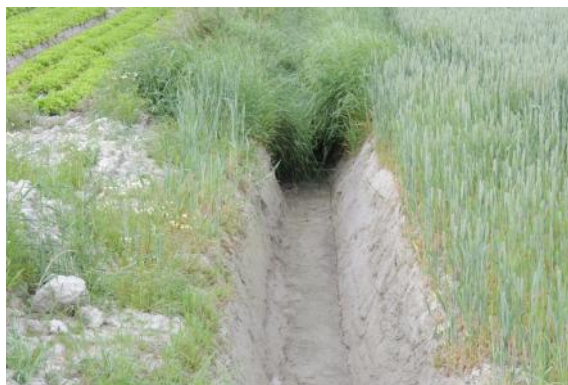
Photo 5 : Un canal fauché puis curé.
