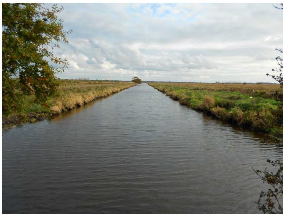
Photo 1 : Le canal de la Boulaie, vue du Pont de Québitre (Brière – Loire-Atlantique, novembre 2015). É. Barussaud
