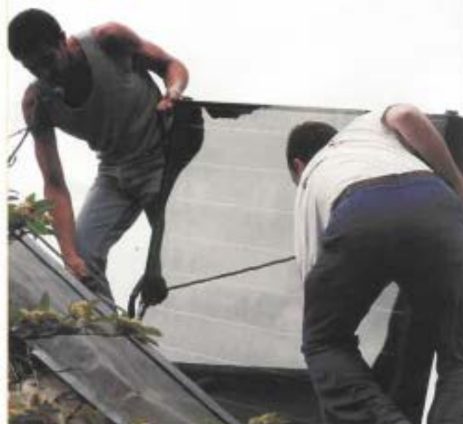
Installation d'un chauffe-eau solaire sur de l'habitat ancien à Morlaix
