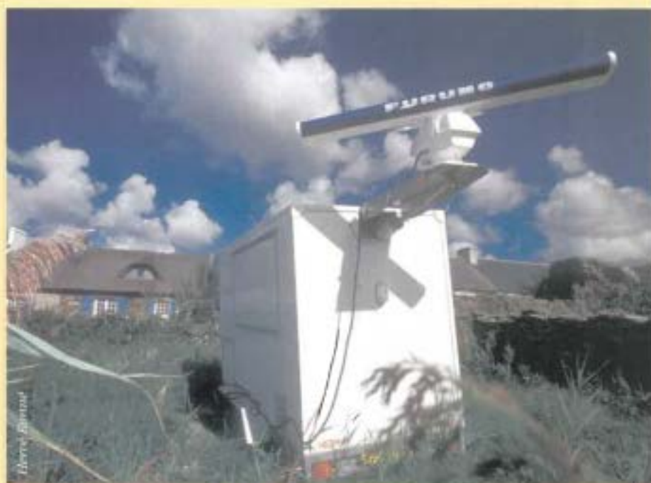
Implantation du radar sur le site.
