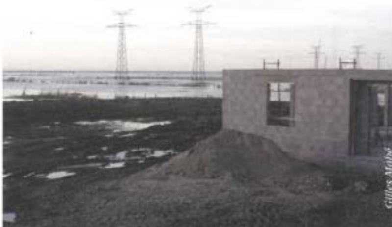
Une construction les pieds dans l'eau ou la délivrance de permis de construire après remblaiements des zones humides.
