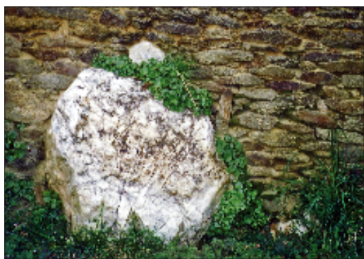
En haut : bourg de Lampaul-Guimiliau ; dans une ruelle à proximité de l'église ; porte avec linteau à accolade, en granite de Plounéour-Menez ; moellons schisteux, plus rarement quartziteux. En bas : Traonlen ; en énorme bloc de quartz en soubassement ; moellons en granite gneissique.
