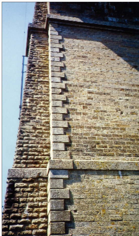
Viaduc de la Penzé près de Lampaul-Guimiliau : chaînage d'angle en granite de Plounéour-Menez ; moellons de parement en granite gneissique ; contrefort (à gauche) en moellons bossués, également en granite de Plounéour-Menez.
