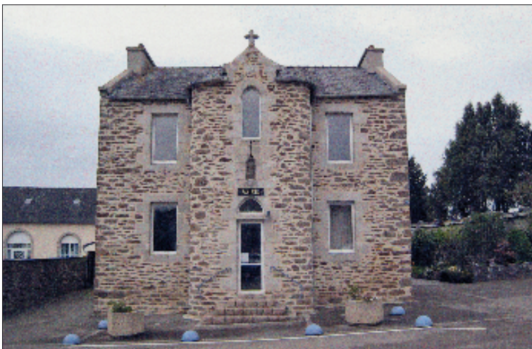
À gauche : dans le bourg de Guimiliau ; maison ; élévation en granite gneissique dont un grand élément est posé de chant, les autres plus ou moins à plat. À droite : Loc-Eguiner-Saint-Thégonnec ; mairie actuelle (ancien presbytère) ; moellons en granite gneissique ; encadrement des ouvertures en granite de Plounéour-Menez.
