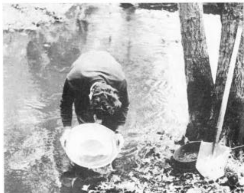
Fig. 38. — Opération du bateyage. Récupération des minéraux lourds au fond de la batée. Auparavant, le gravier a été prélevé à la pelle et tamisé au-dessus de la batée.
