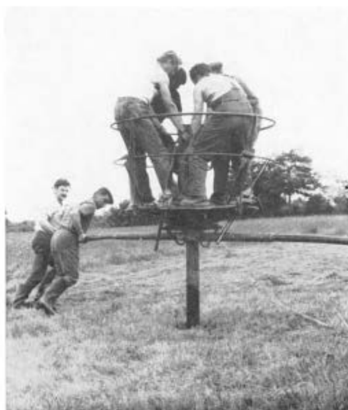
Fig. 39. — Exploration des alluvions à la sondeuse Banka.
