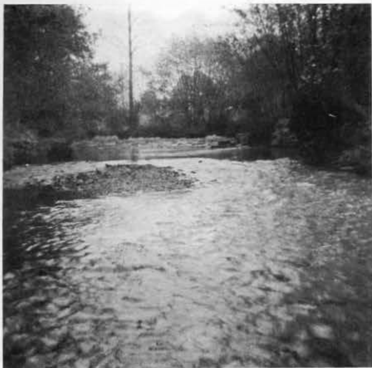
Le barrage de Maigué après le nettoyage du lit et des berges.
