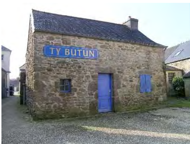
Vue extérieure avant travaux
