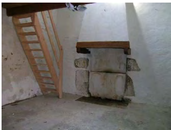
Vue intérieure du RdC avant travaux
