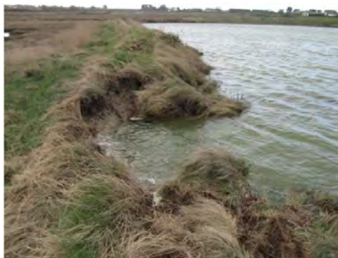
Digue du bassin G10 à Dolan.
