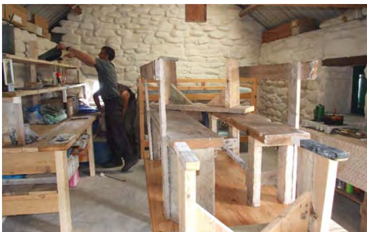
Intérieur du refuge de Banneg, chaulé et réaménagé
