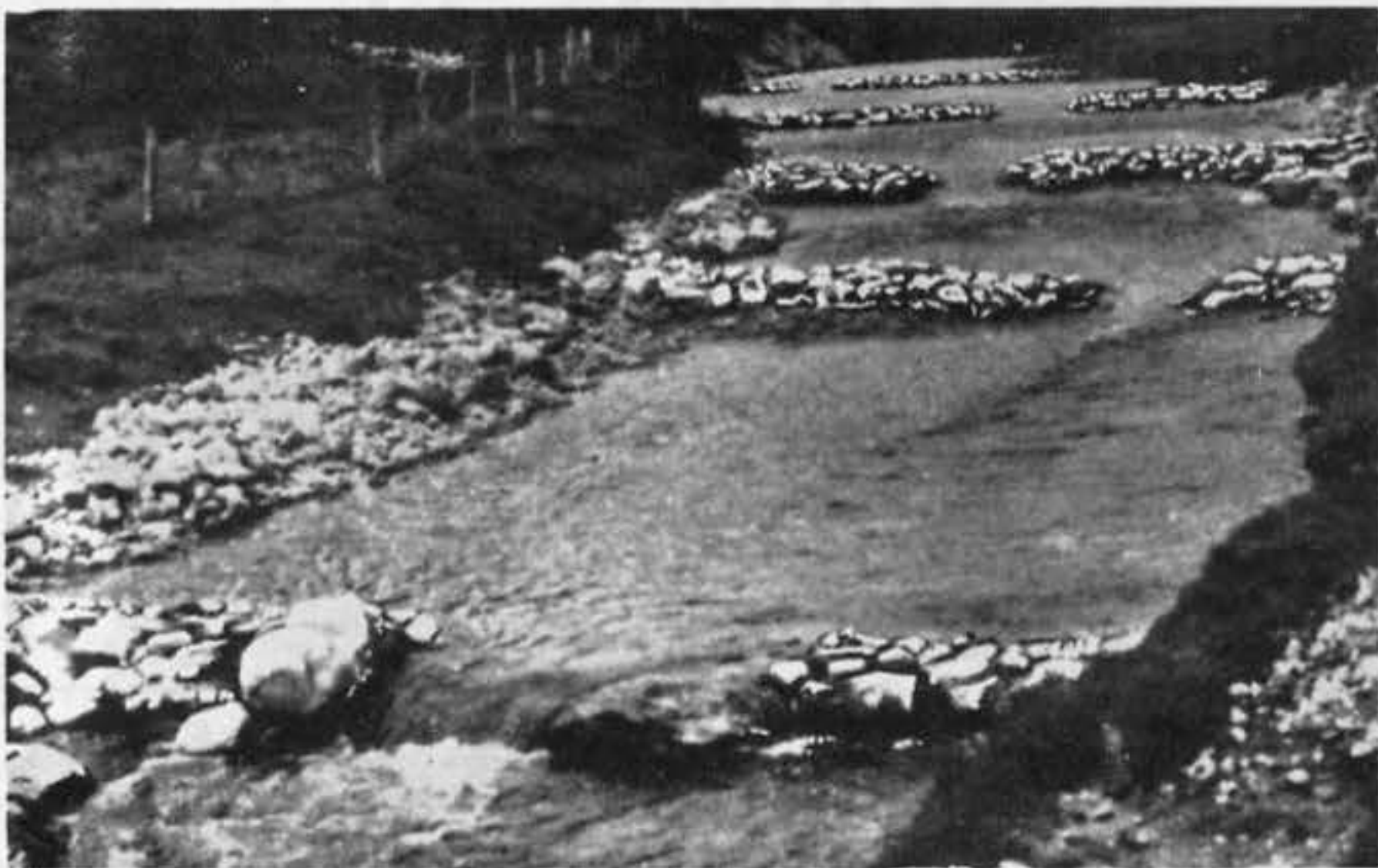
Barrages terminés, vue vers l'amont.
