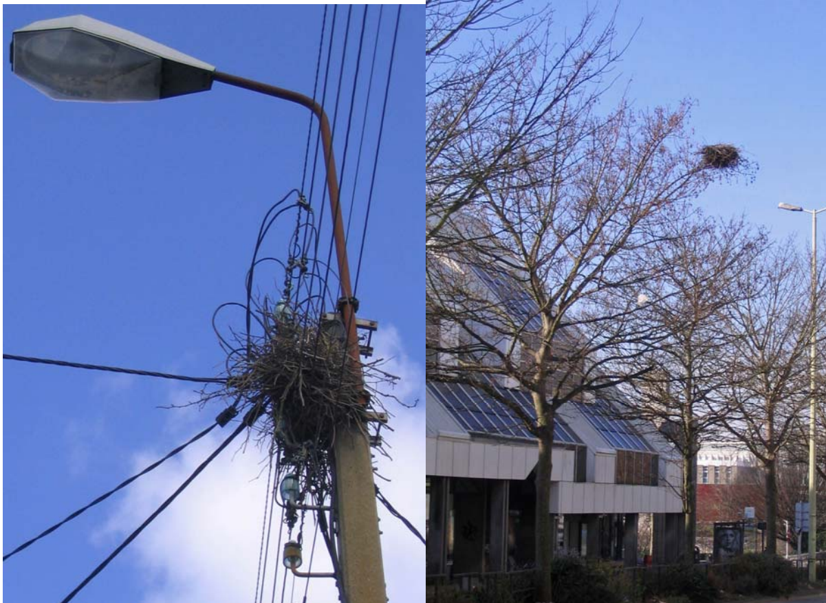
photo 1 & 2 : différentes situations de nids urbains (Brest - Finistère, avril 2005 & février 2007). D. Clech
