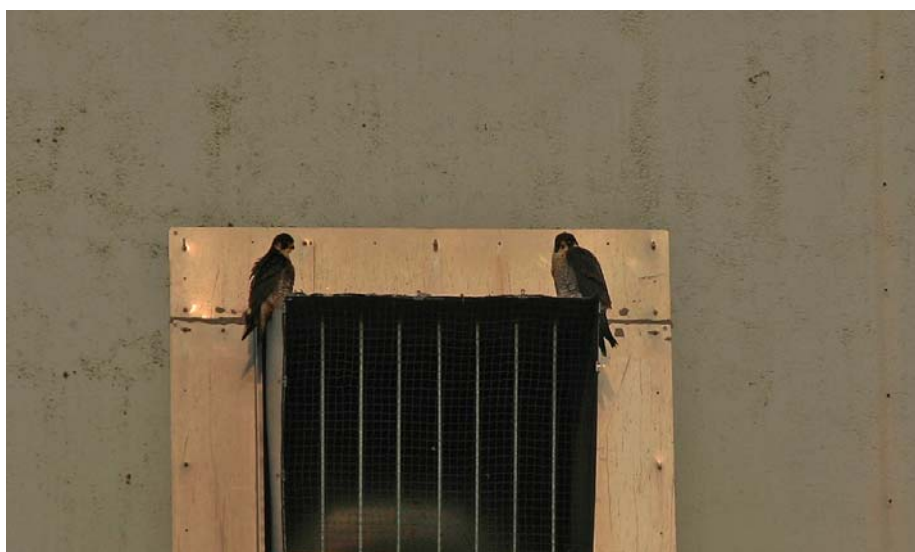
photo : deux oiseaux posés sur un aérateur du silo du port (Lorient - Morbihan, janvier 2009) J. Serrano
