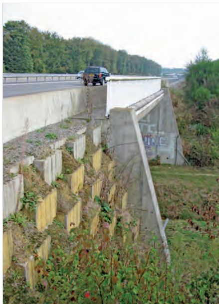
Passage à faune monumental pour animaux de toute taille et permettant l'écoulement de l'eau
