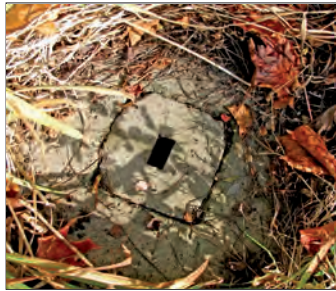
Compteur d'eau : regard ouvert (à gauche) ; regard « fermé » (au milieu) ; trou obturé par une ardoise (à droite)
