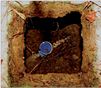
Compteur d'eau : regard ouvert (à gauche) ; regard « fermé » (au milieu) ; trou obturé par une ardoise (à droite)
