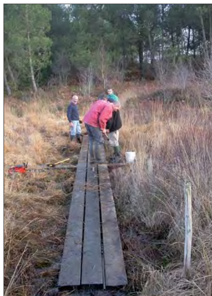
Réalisation d'une passerelle pour faciliter le passage.
