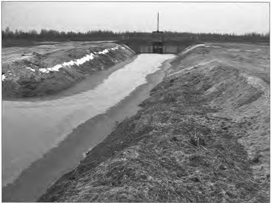
Écluse aménagée sur le canal Paviedskyt.
