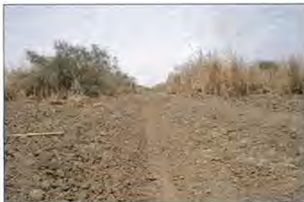
En juin 2008, des travaux hydrauliques (entretien des canaux) ont été réalisés pour permettre une meilleure circulation de l'eau dans le Parc.
