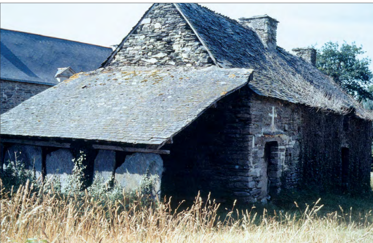
Un seul apprentis pour tout bâtiment d'exploitation. La Touche Morgan en Sérén, Morbihan.
