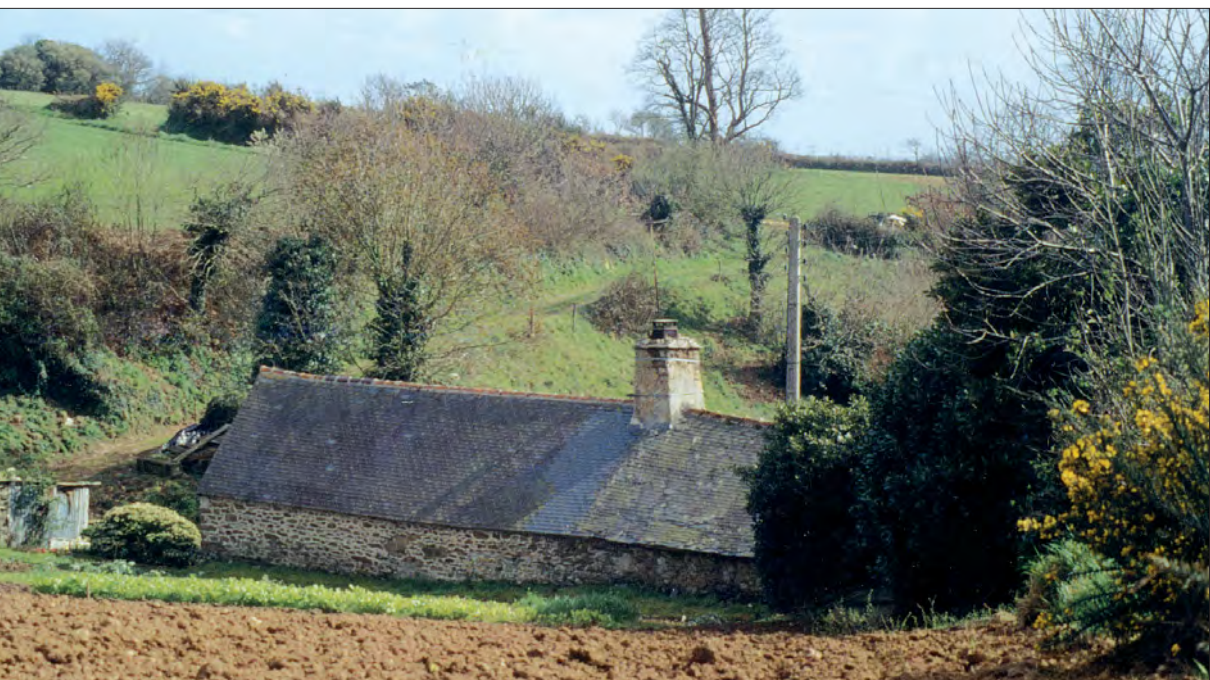
Le jardin potager est souvent situé derrière la maison ; celle-ci est engagée dans la déclivité du terrain de telle sorte que l'égout du toit se trouve pour ainsi dire au niveau du sol quand la maison ne comporte pas d'étage. Stang-Guéguen en Plouzané, Finistère.
