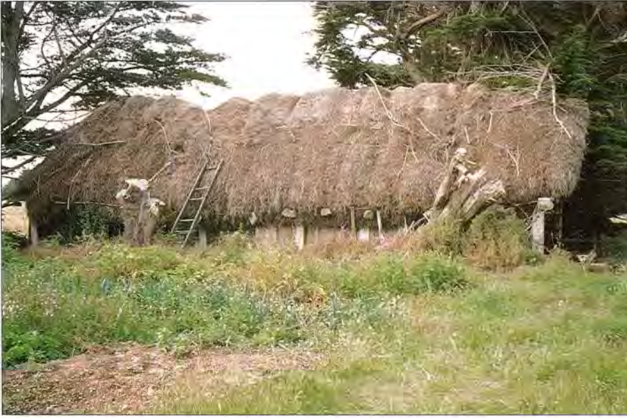
L'un des hangars restants du siècle dernier, couvert de "mottes de terre et gerbe de landes". Cette toiture sommaire est maintenue par des cordages passant au dessus du faitage et lestés par de grosses pierres à chaque extrémité.
