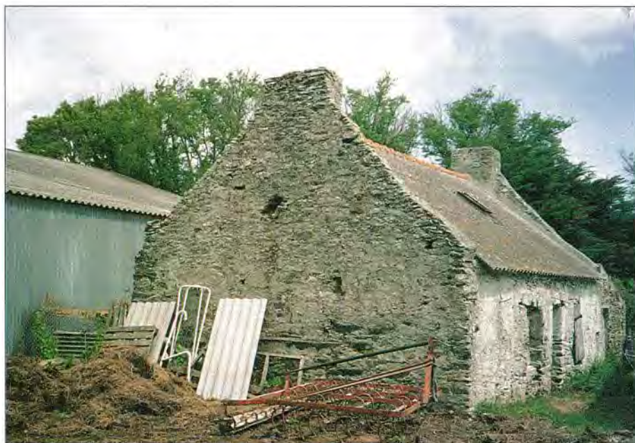
Maison de Parlevan (1767), où l'on voit nettement la surélévation des bas de rempans de pignons, pour permettre d'adapter la toiture à une pente moins accentuée.
