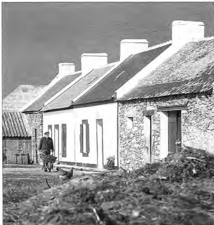
A Belle-Ile, les enduits des maisons étaient traditionnellement rajoutés au lait de chaux tous les ans, le lundi de Pentecôte.
