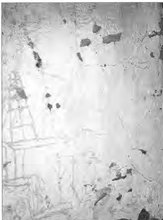
Graffitis dans l'appentis d'une maison d'Arnaud, montrant les cotres-pilotes dont les patrons (une quinzaine à Locmaria) occupaient un échelon élevé dans la hiérarchie sociale et dont les maisons se distinguaient des autres par un toit à quatre pentes et des fenêtres cintrées.
