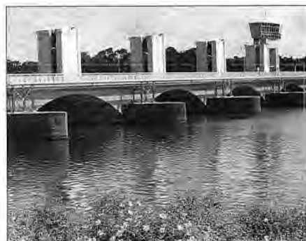
Le barrage d'Arzal vu de l'amont.
