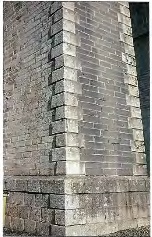
Vue partielle d'une des piles du viaduc du Ponthou (pose de la première pierre en 1861). Parement vu de la partie basale en granite porphyroïde du Ponthou. Au-dessus, chaînes d'angle en granite de Guerlesquin ; moellons clairs (à gauche) en granite de Guerlesquin ; moellons sombres (à droite) en diorite de Lanvellec.
