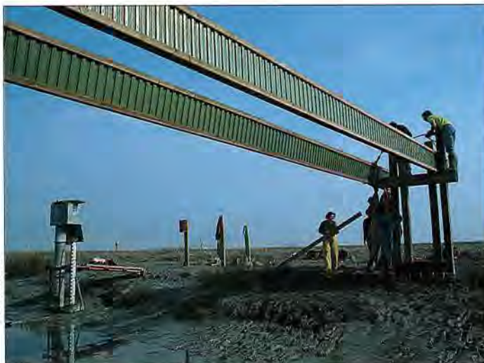
La mise en œuvre des programmes de recherche mobilise des moyens importants en matériel et en main d'œuvre. Ici, la construction de la station expérimentale par les chercheurs et étudiants du laboratoire (au second plan, le limnigraphie).
