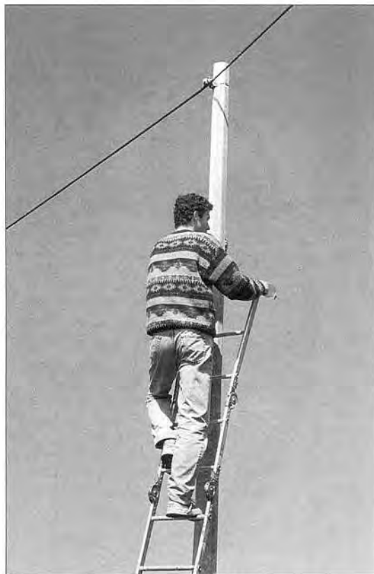
Le bouchage systématique des poteaux creux, opération fastidieuse, est indispensable pour éliminer définitivement ce facteur de mortalité.
