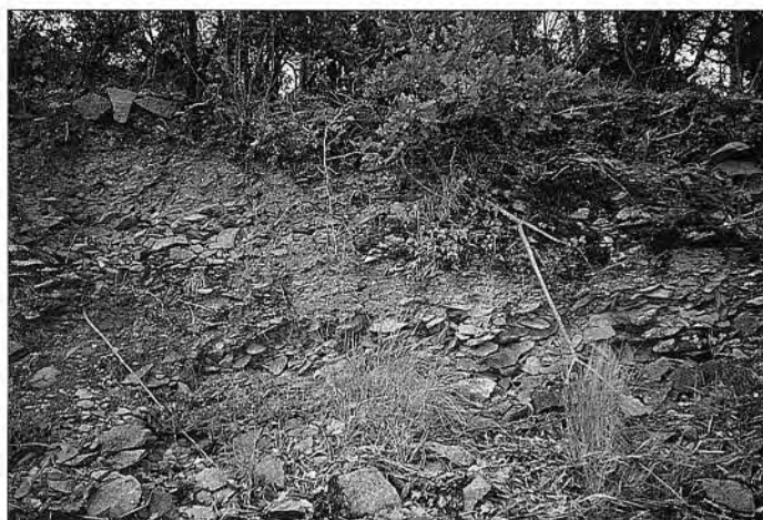
A l'Ouest-Sud-Ouest du village du Run, accumulation de débris de taille (14/10/96).
