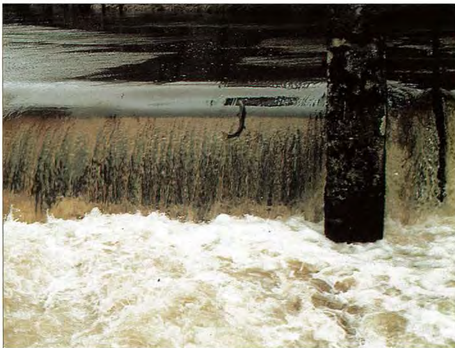
Adulte de saumon atlantique en train de franchir le barrage de Pont-Callec sur le Scorff ; ce barrage construit au début des années 1920 a été équipé d'une passe à poissons vers 1935 rive droite, sur la gauche, hors de la photo.
