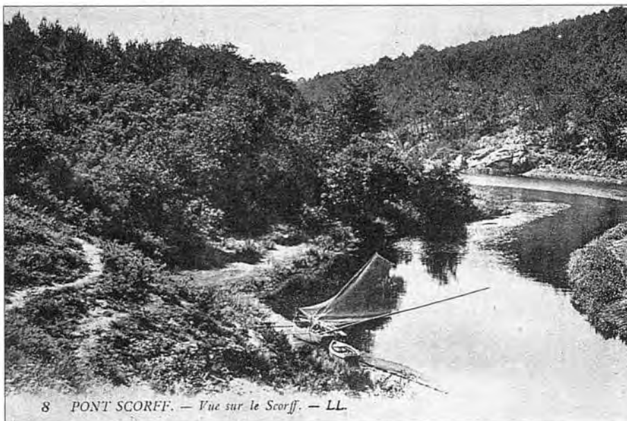
Grand haveneau monté sur bateau pour la pêche du saumon dans l'estuaire du Scorff (d'après une carte postale du début du XX e siècle : prêt de François Nevannen). Trois chaloupes de ce type ont été observées par Le Masson du Parc lors de son passage au bourg de Pont-Scorff au début du XVIII e siècle (A.N. Marine C/5/21).
