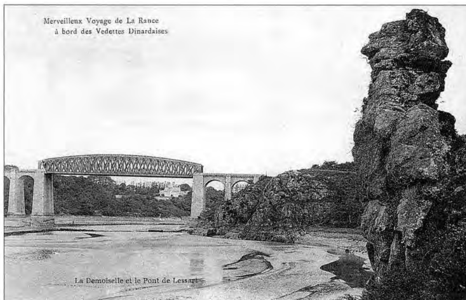
Falaise de "granulites feuilletées" de Lessart ; on distingue le chenal de navigation bordé d'enrochements (ligne sombre sous la pile gauche du viaduc) ayant entraîné dès le début du siècle un envasement de cette partie de la Rance.
