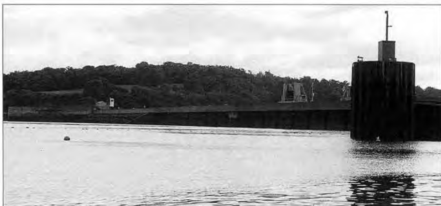
Vue aval du barrage marémoteur.
