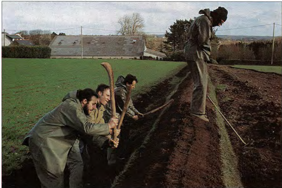
Ecole du talus, St Thonan ; tassement au pied du haut du talus et travail au baton. A droite, on voit la zone de prélèvement des mottes.
