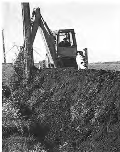
Racler un peu de terre ; tasser au fur et à mesure. Quelle longueur en peu de temps!
