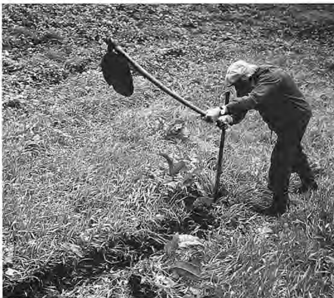
Préparation des mottes pour construire le talus avec une vieille marre.
