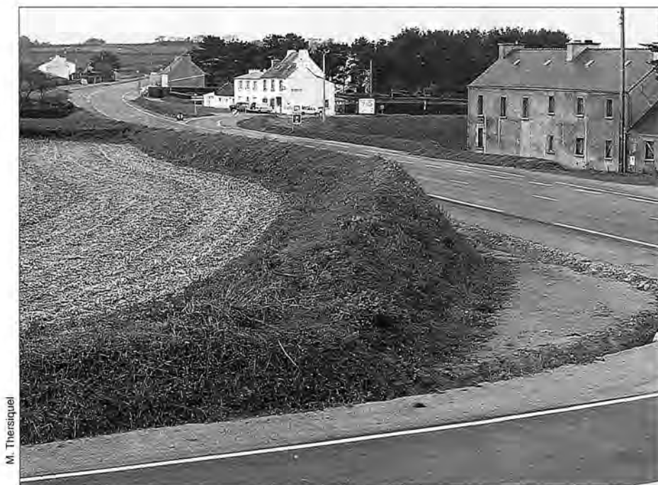
A Locmaria -Plouzané (Finistère) un talus nouveau construit à l'engin par les services départementaux lors d'un réaménagement routier en 1991.
