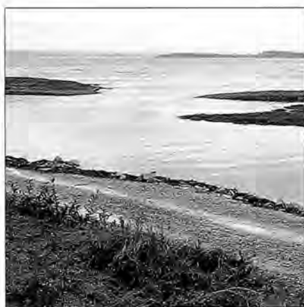
La brèche à haute mer avant les travaux de restauration du site au mois de janvier 1994.
