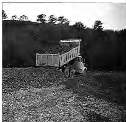
Travaux de restauration de la flèche externe le 21.1.1994.
